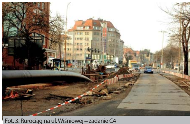
Fot. 3. Rurociąg na ul. Wiśniowej – zadanie C4
