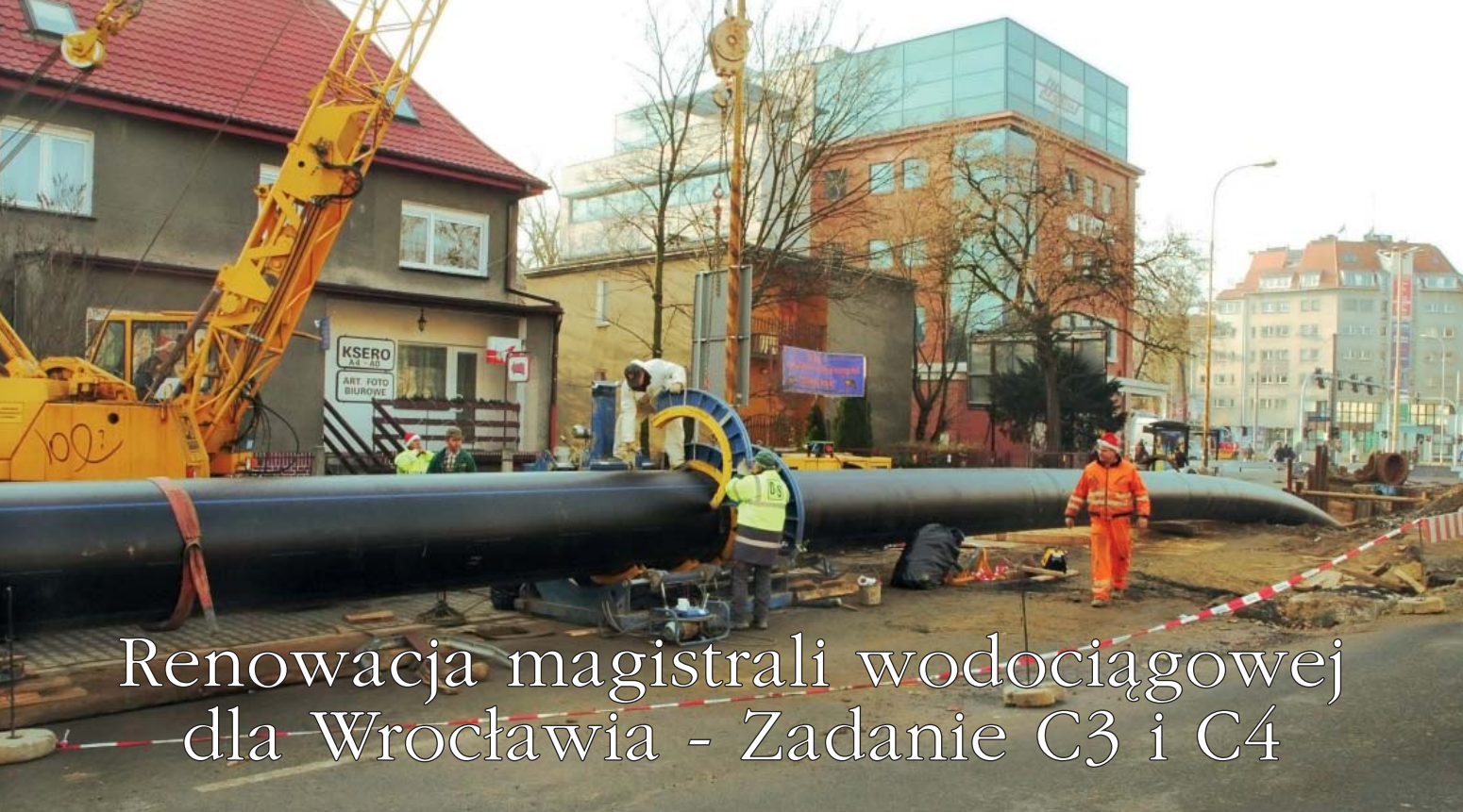
Fot. 1. Zgrzewanie rur poza komorą na ul. Wiśniowej – zadanie C4
