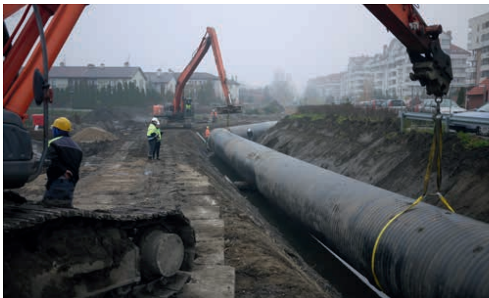
Układanie rurociągu w przygotowanym wykopie kanału
